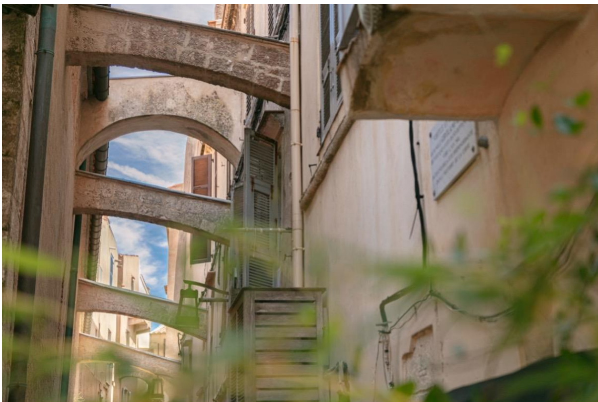
Les arcs de l'église Ste Marie-Majeure accueillent les conduites d'alimentation en eau de sa citerne souterraine, qui date du XIV e siècle.
