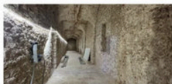
Le grand couloir du rez-de-chaussée sera transformé en salle d'exposition.
