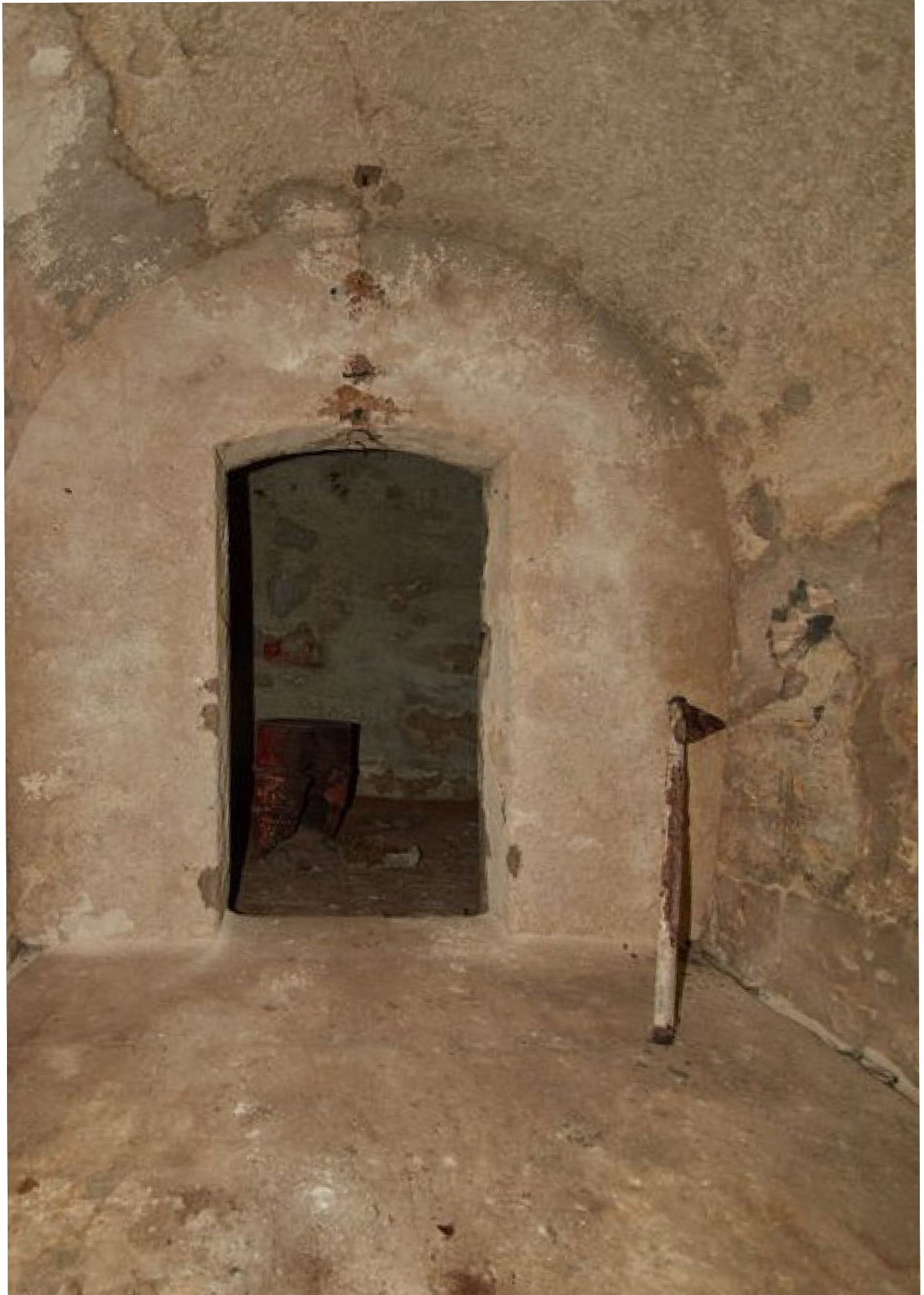
Magasin à poudre, partie enterrée. Photo Mairie de Bonifacio.
