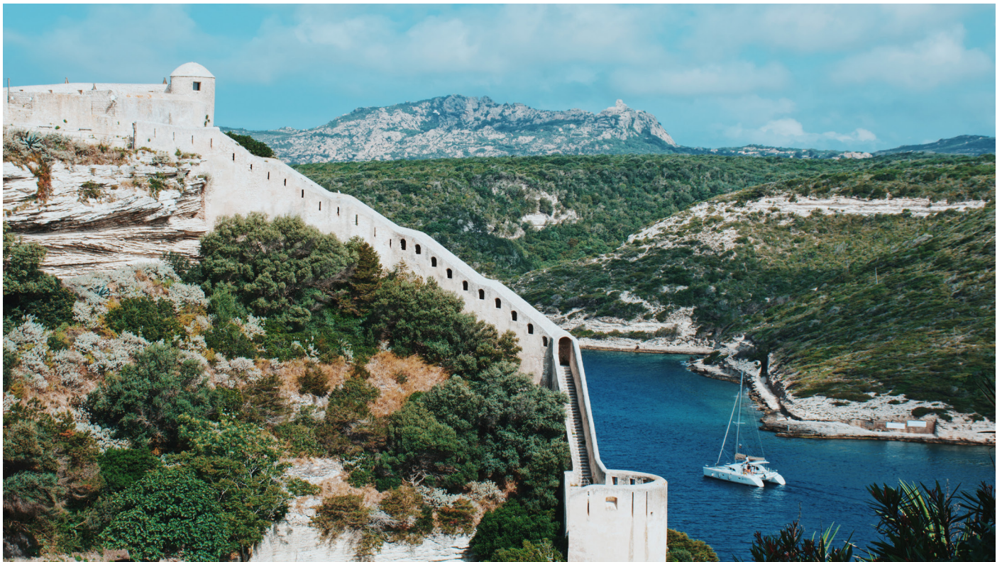
Vue sur les remparts de Bonifacio, en cours de restauration. Batterie de la Carrotola. Photo Faustine Poingt
