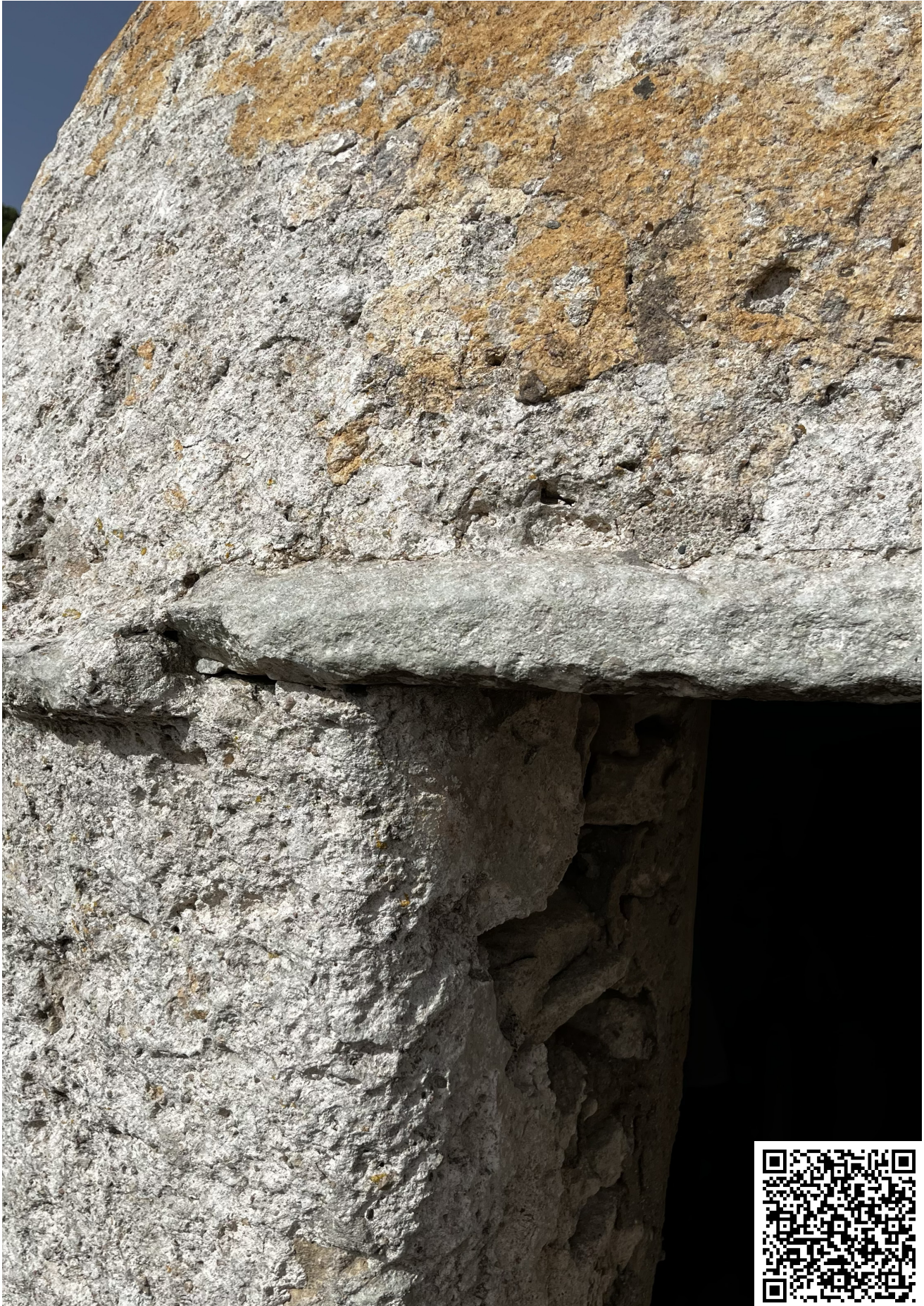
Vue de la Batterie Saint-Barthelemy, en cours de restauration. Photo Mairie de Bonifacio.
