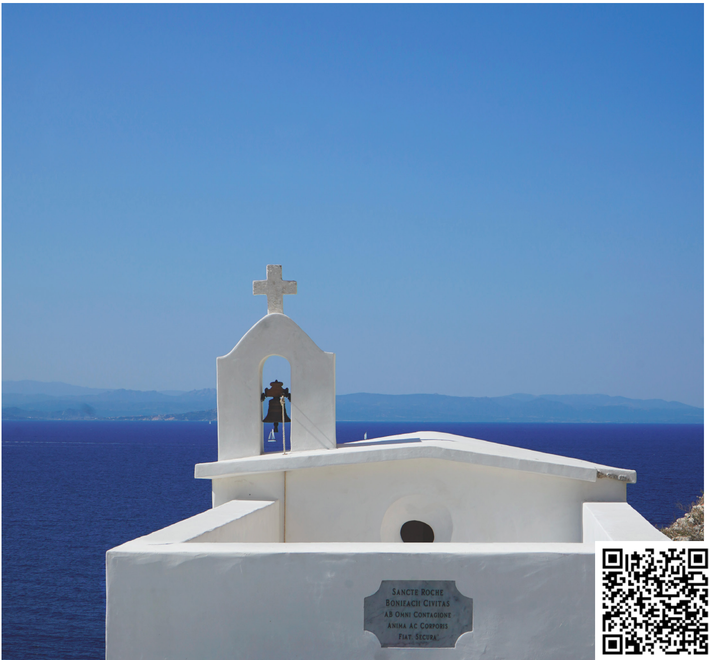
La Chapelle Saint-Roch, avant et après restauration. Photos Mairie de Bonifacio
