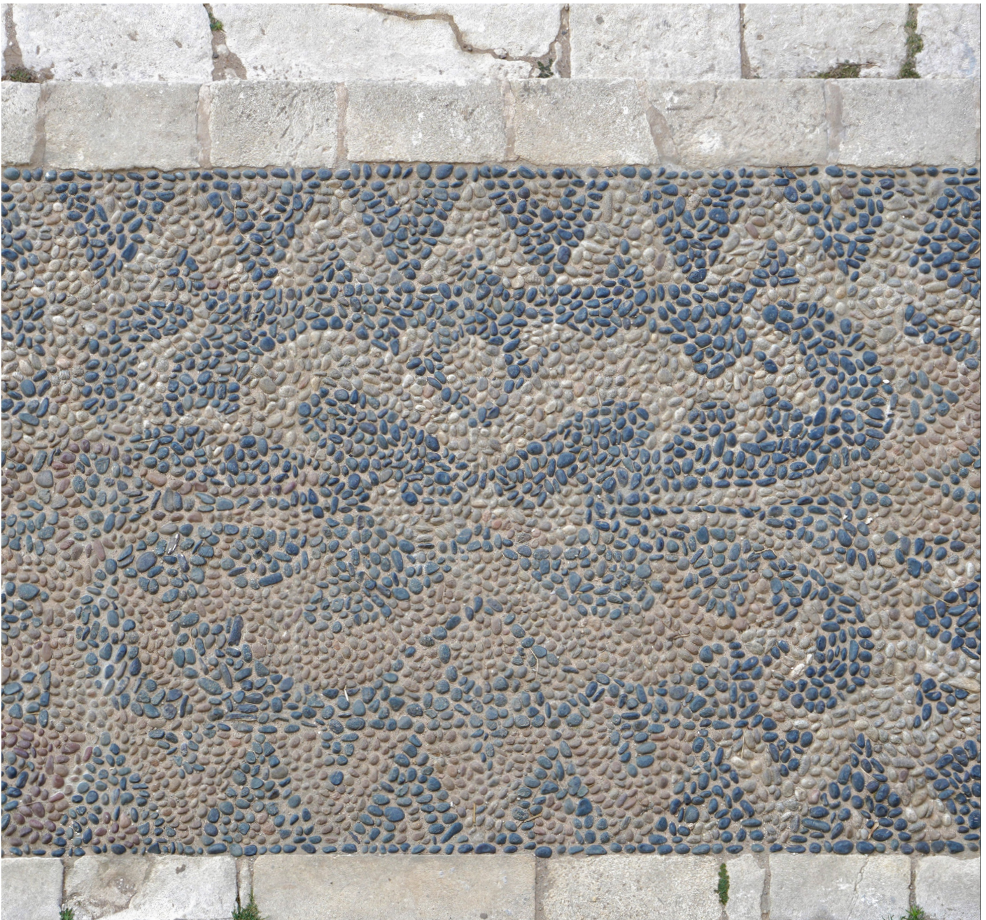
Deux des quatre cartouches qui composent la calade Saint-François, motif à reconstituer, photo Perrot & Richard Architectes. Photo après restauration, Mairie de Bonifacio.
