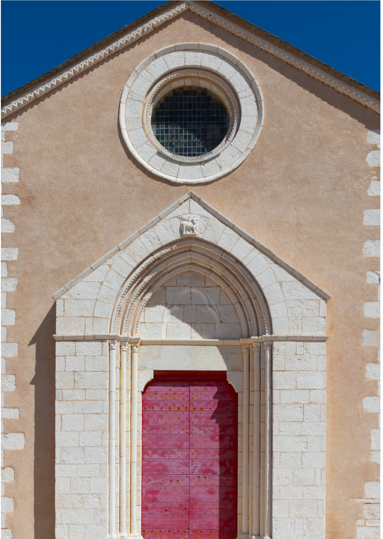
L'église Saint-Dominique, au cœur du quartier Pisan. Les enduits extérieurs, le toit et le clocher ont déjà bénéficié d'une restauration. Photo Mairie de Bonifacio.
