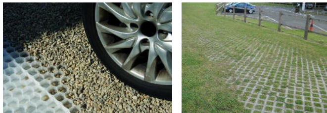
Exemples de revêtements perméables et carrossables
