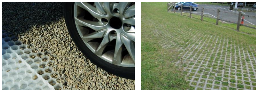
Exemples de revêtements perméables et carrossables
