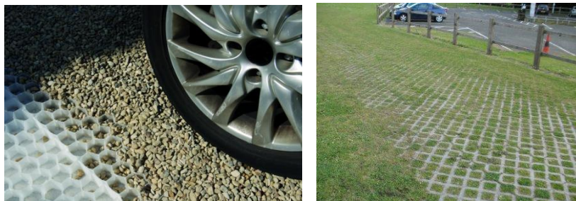
Exemples de revêtements perméables et carrossables
